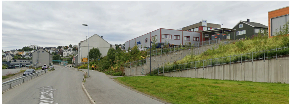
Gatebilde fra Hansjordnesgata mot sydvest, til høyre eksisterende bygg og del av brannstasjon.
